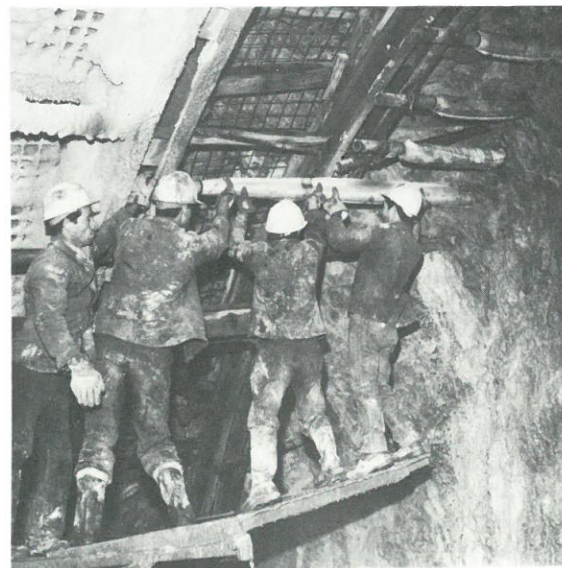
Fig. 20 - Posa di un tubo di infilaggio nella galleria stradale di Limina. Si può notare il tessuto che avvolge il tubo per il suo rapido "ammarraggio" alla roccia
