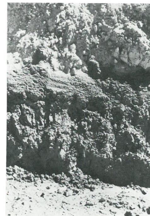
Fig. 6 - Uno scavo in roccia molto alterata e con alto grado di dispersività. Dai frammenti occorsi nella parete laterale si deduce come la presenza d'acqua riduca ulteriormente le proprietà meccaniche di questo tipo di formazione
